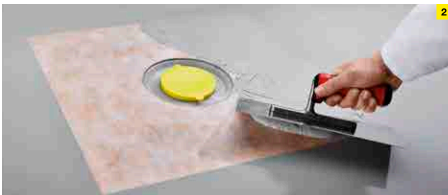
Application de la 2 e couche d'étanchéité à l'aide d'une combinaison bicomposant synthétique et mortier de ciment, qui a fait ses preuves dans la pratique.
